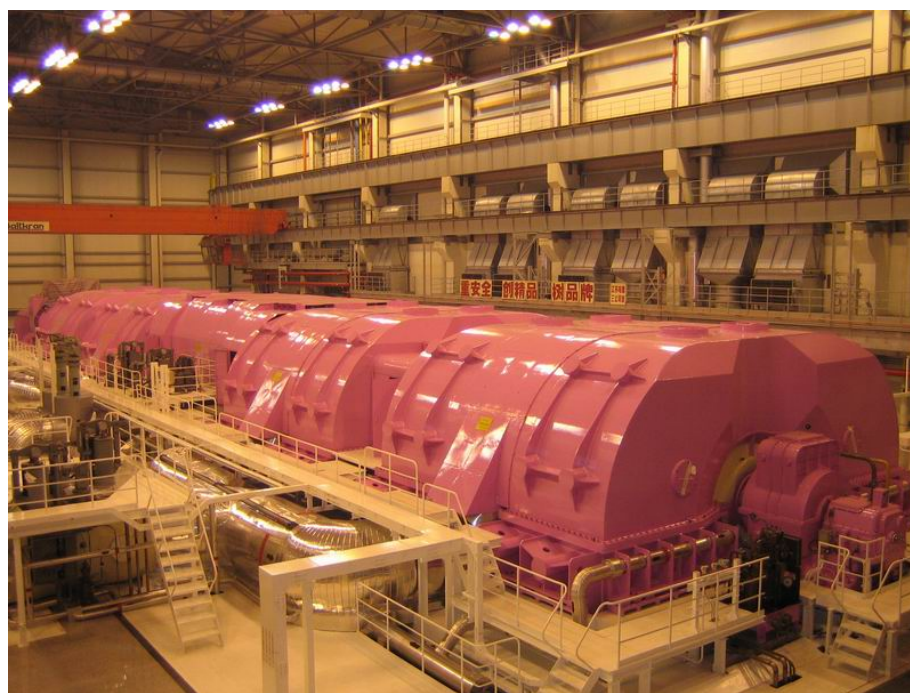
Рис. 1. Быстроходная паровая турбина мощностью 1065 МВт на АЭС Тяньвань
