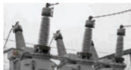
Рис. 2. Трансформатор ТВ-110-IX.
