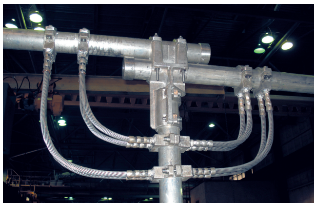
Узлы соединения разборной жесткой ошиновки
